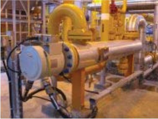
Pueden suministrarse recalentadores para trabajar en zonas clasificadas ATEX. En cada caso se aplican a la fabricación del recalentador las características que se corresponden con la directiva de la zona de trabajo. Pueden conectarse, hidráulicamente, en serie o en paralelo y responden a las exigencias de la directiva europea DESP. Los recalentadores antideflagrantes están sujetos a un examen de tipo por LCIE y se ajustan a la norma EN 60097-0.
